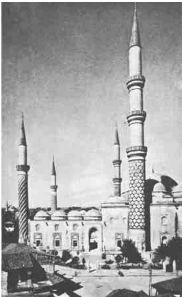
مسجد أوج شرخلي - منظر عام طراز سلجوقي
